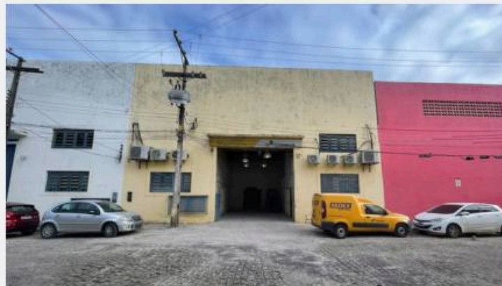
OBRA: CDD SANTO ANTÔNIO ANO: 2026 CLIENTE: CORREIOS
