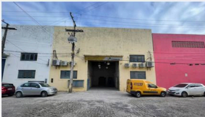
OBRA: CDD SANTO ANTÔNIO ANO: 2026 CLIENTE: CORREIOS
